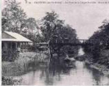
Vue sur le pont qui enjambe la Crique Fouillée au début du XX ème siècle (projet Babel)
